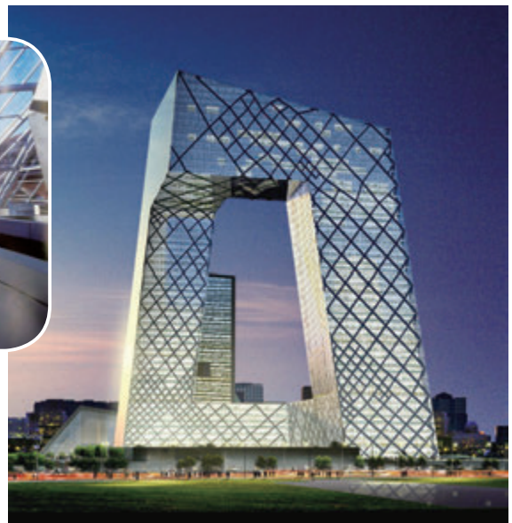
中央电视台总部大楼 2004 年 [荷兰] 雷姆·库哈斯等
